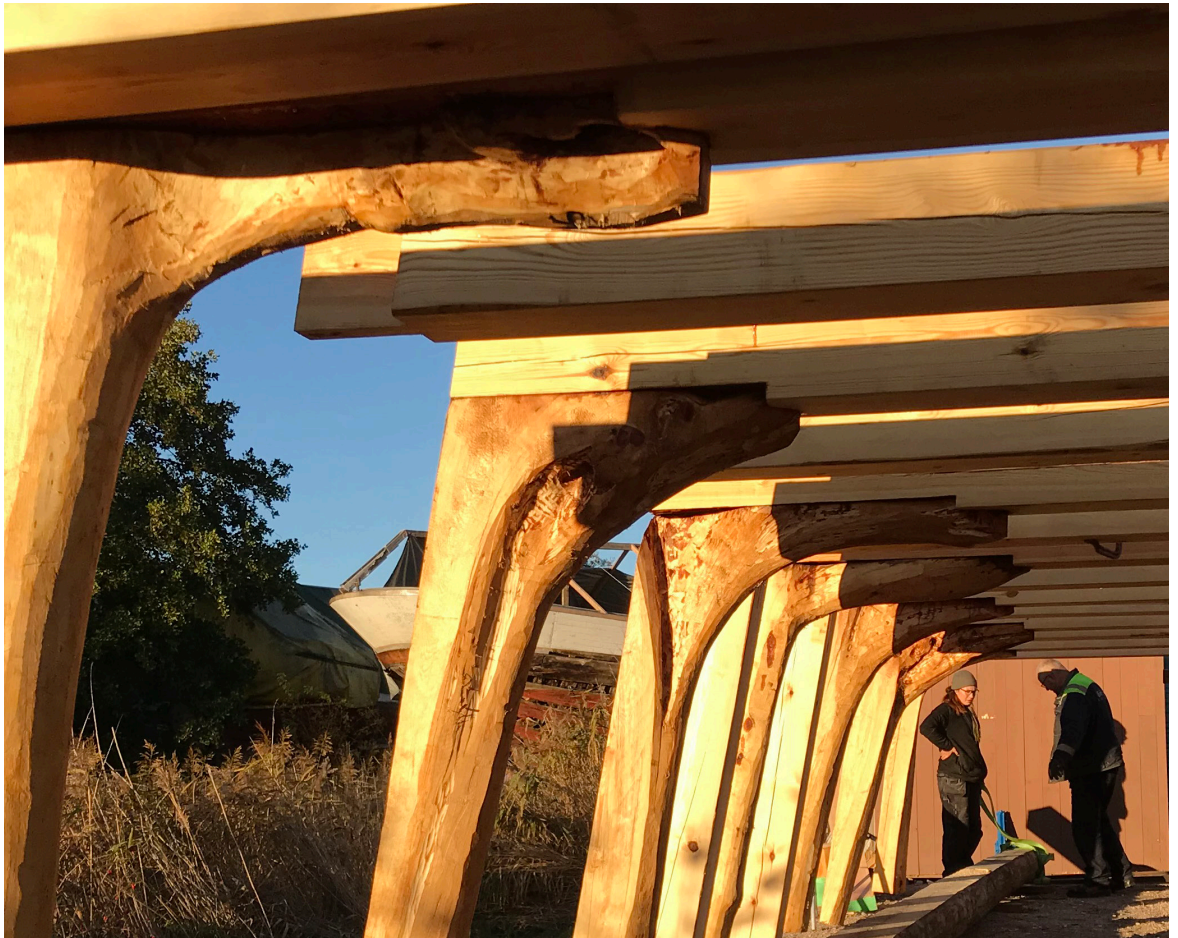
Tilsammen 46 røtter har gått med for å lage spuntene i prammen.
